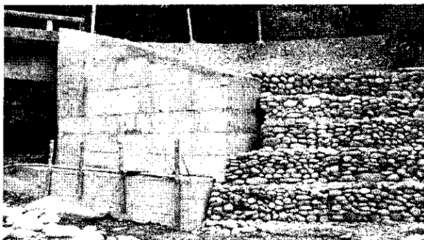
Foto 29. Estribo Derecho Aguas Abajo – Perfil – Año 2015
