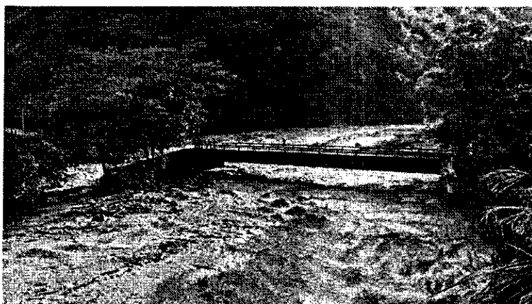
Foto 3. Puente de Viga de Concreto – Perfil Aguas Abajo
