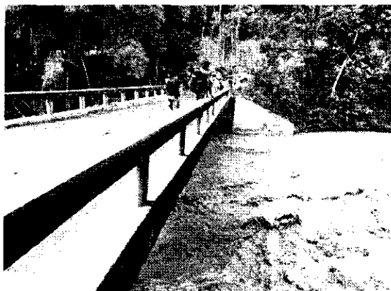
Foto 11. Baranda - aguas abajo.
