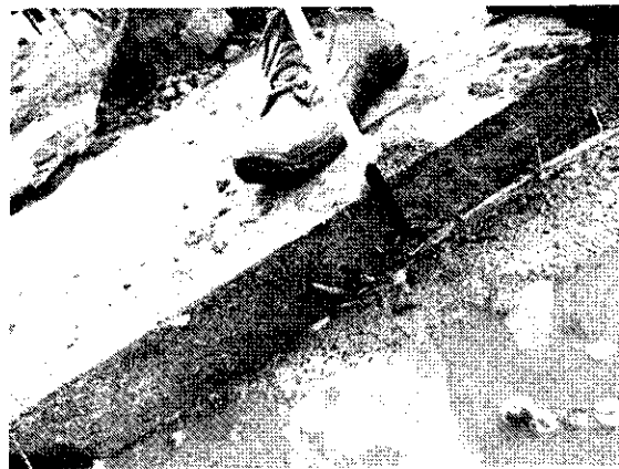
Foto 6. Asentamiento Losa de Concreto 2.
