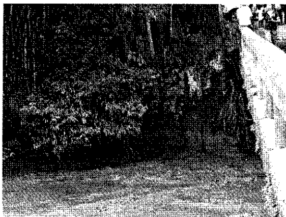
Foto 23. Estribo, Costado izquierdo aguas abajo.
