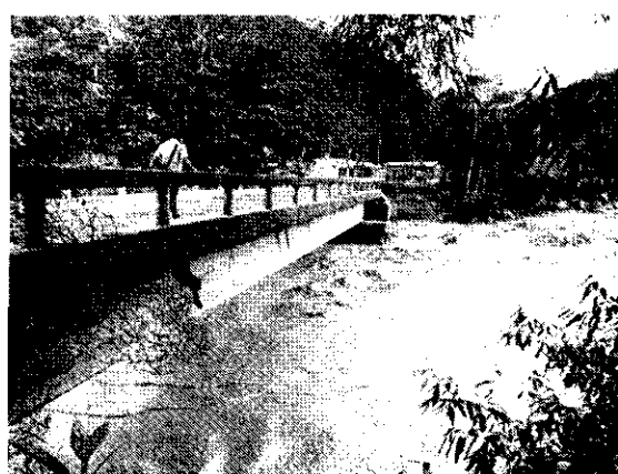
Foto 10. 1ª Viga - aguas arriba.
